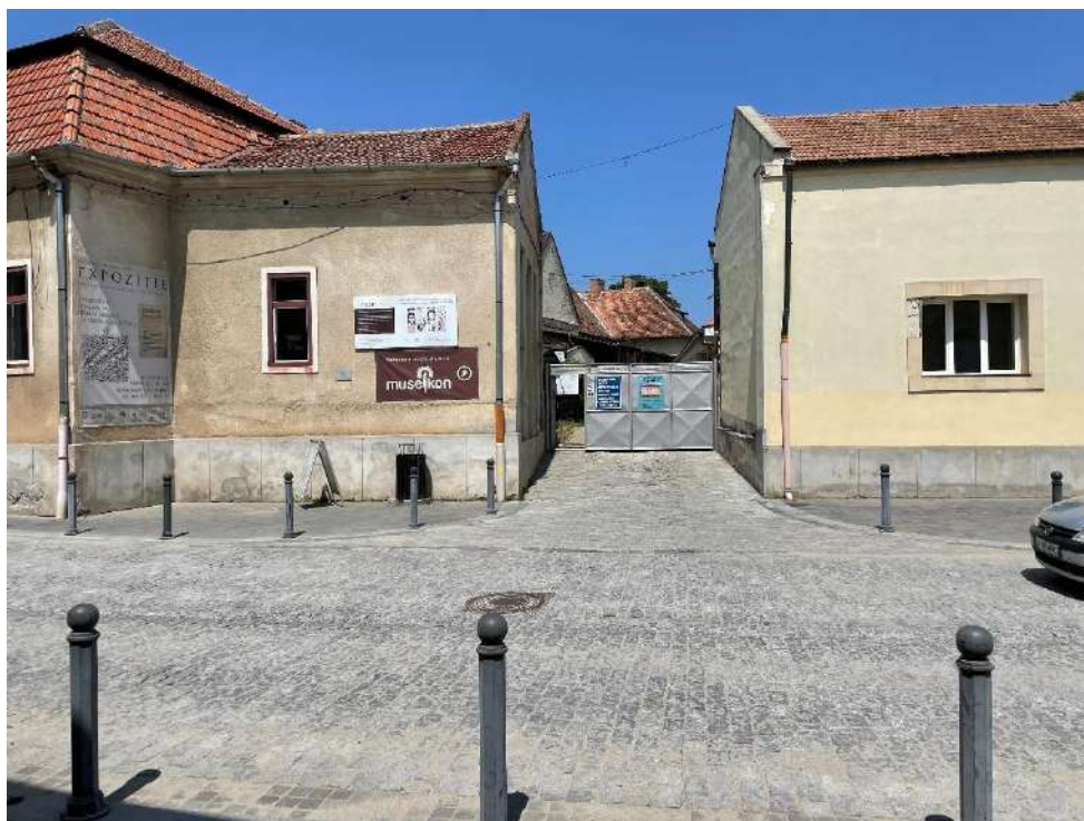
Figura 1. Rampa acces auto existentă
