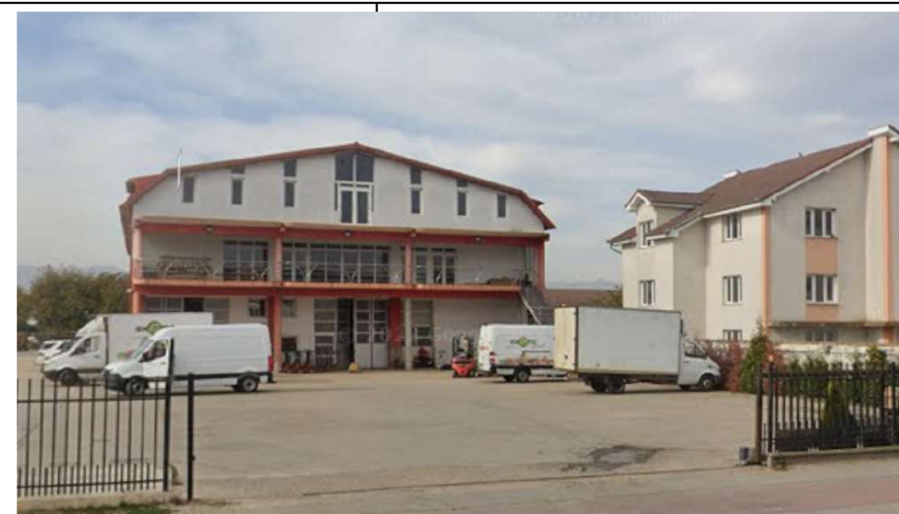
Perspectivă existentă din zona str. A.I. CUZA
