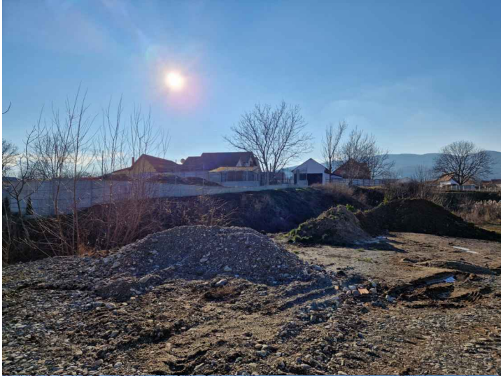
vedere taluz spre pârâu
