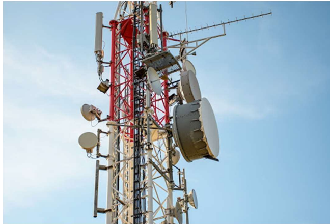
Fig. 6.7 Site Celular 5G marca Ericsson - compatibil 3GPP și 5G NR (New Radio)
