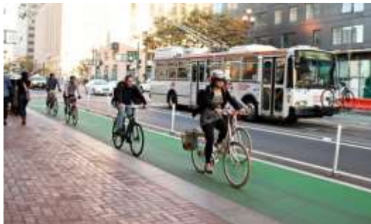
Figură 34 - Exemplu de piste protejate pentru bicicliști (Locația: Market Street San Francisco)
