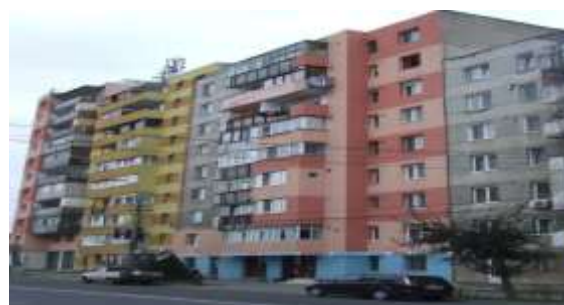
Figură 141 - Bloc de locuințe cu fațadă multicoloră și inestetică în urma reabilitării termice a unor locuințe (cartier Ampoi 1)
