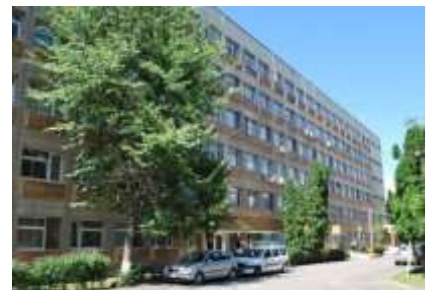
Figură 108 - Clădirea Spitalului Județean de Urgență Alba
