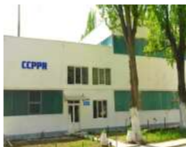
Figură 122 - Centrul de Cercetare, Proiectare și Producție Refractare
